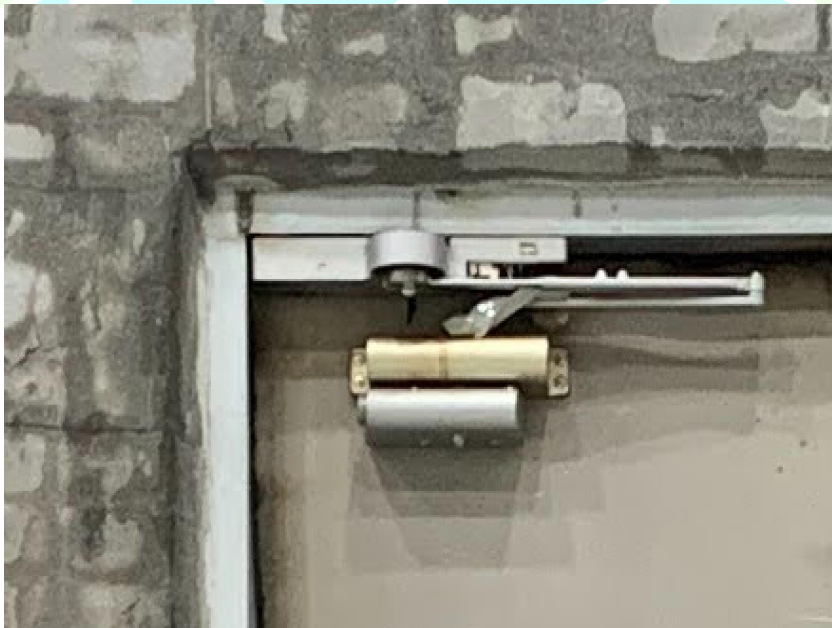
< 시험 후 - 자동폐쇄장치 >
